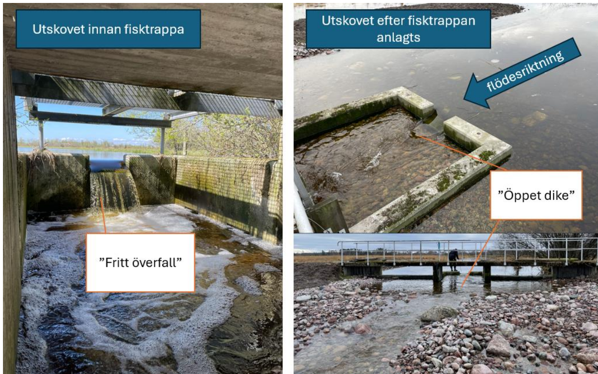
Figur 2. Utloppets utformning före och efter att det nya utskovet med fisktrappa anlagdes 2024.
