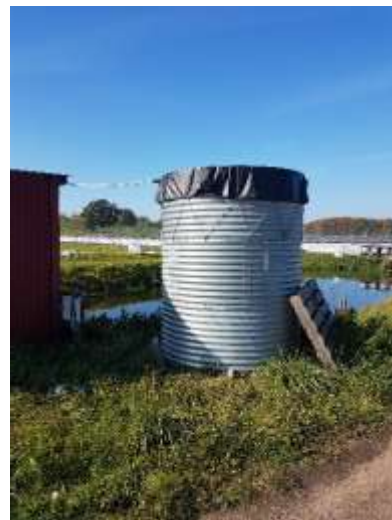
Mellanlagring av returvatten och regnvatten är vanligt i cisterner med lock.
