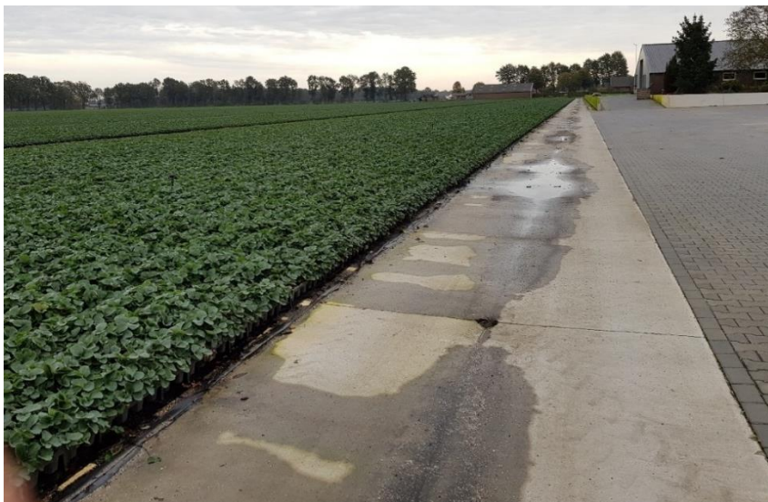
Bild 16. Uppsamling av returvatten i tray-plantproduktion. plantorna står på plasttäckta mark som leder vattnet till betongrännor med dränering.
