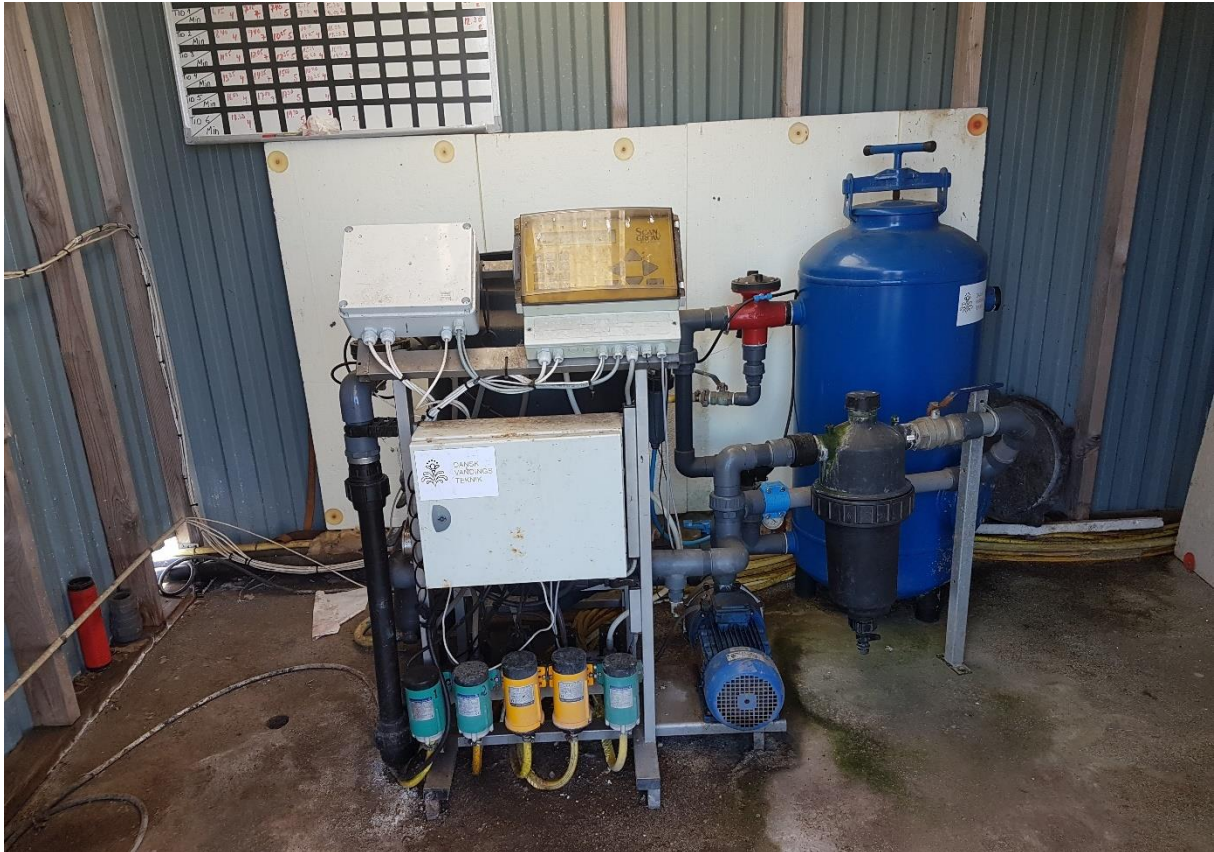
Gödselblandare med bevattningsdator. Blandningen sker i det mörka karet som döljs av apparaterna. I bakgrunden står ett blått sandfilter.
