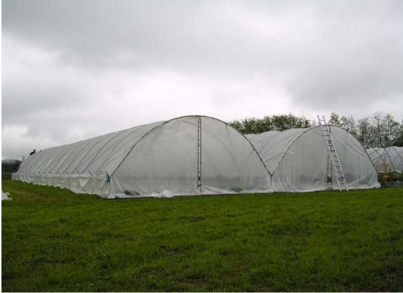
Tunnlarna kompletterades med dörrar på gavlarna, i Öjebyn, maj 2010. E.Öberg
