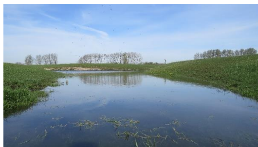
Bild 1. Nyanlagd multifunktionell våtmark med grunda partier vid inloppet och varierande släntlutningar i kanter. Syftet: näringsretention och biologisk mångfald.
