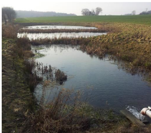
Bild 2. Segmenterad våtmark i Danmark där vegetationsklädda åsar har anlagts vinkelrät mot flödesriktningen.
