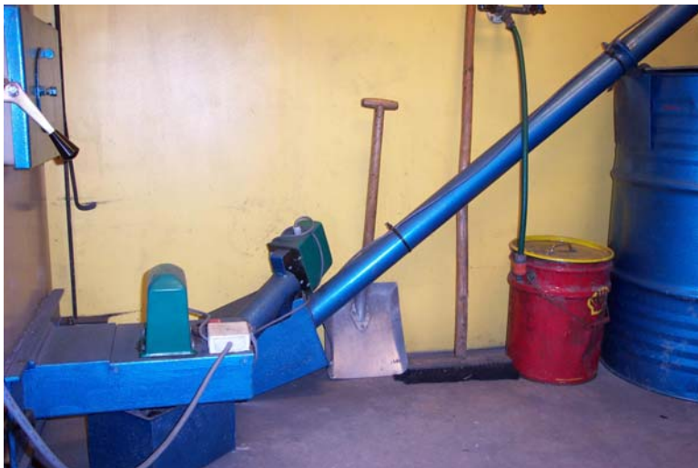
Bild 10. Automatisk uraskning med skruvtransport till begagnat oljefat.
