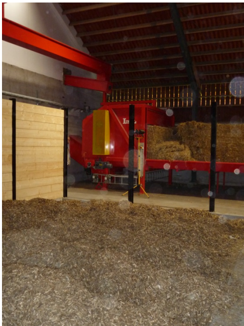
Visning av bränsleinmatning för flis och halm samt Linkapannan på 3 MW.
