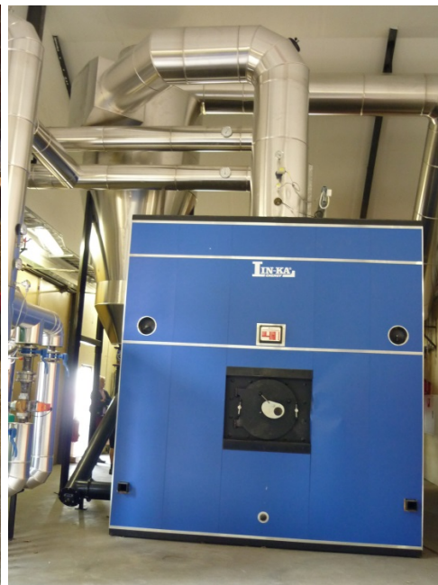
Visning av bränsleinmatning för flis och halm samt Linkapannan på 3 MW.
