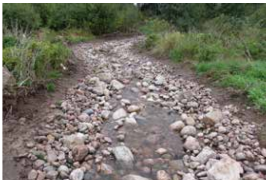
Figur 3. Till vänster: en tidigare kulverterad sträcka har öppnats till ett levande vattendrag i Stjärnarp i projektet LIFE-Goodstream. Till höger: vi har lagt in sten i delar av den nya sträckan som leder in till en nyrestaurerad liten våtmark. Tanken är att det ska gynna fiskvandring och även andra djurarter i Trönningeån. Foto: John Strand.
