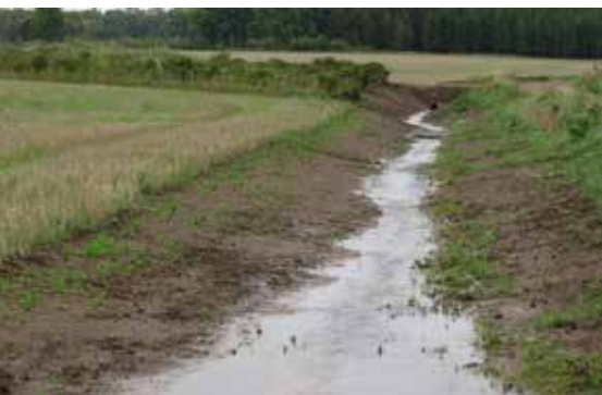
Figur 3. Till vänster: en tidigare kulverterad sträcka har öppnats till ett levande vattendrag i Stjärnarp i projektet LIFE-Goodstream. Till höger: vi har lagt in sten i delar av den nya sträckan som leder in till en nyrestaurerad liten våtmark. Tanken är att det ska gynna fiskvandring och även andra djurarter i Trönningeån. Foto: John Strand.
