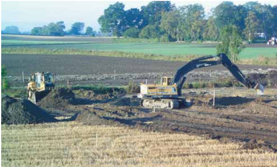
Dammbyggnation, Lyckås, Kristianstad. Foto: Peter Malm, Hushållningssällskapet Kristianstad
